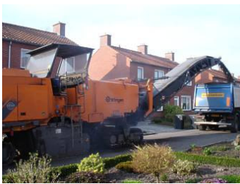
Het verwijderen van het wegdek.
