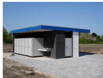
Het nieuwe toiletgebouw.
