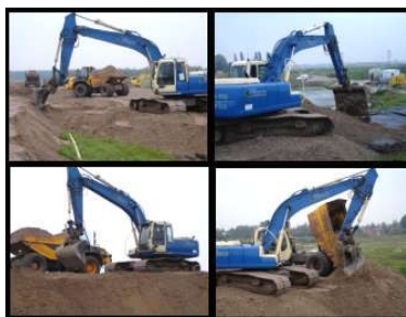
Het verzwaren van de zwakke dijk.
