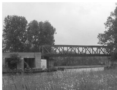
De spoorbrug uit de jaren dertig.
