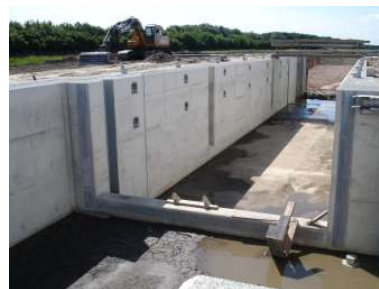
De nieuwe sluis bij de A7.
