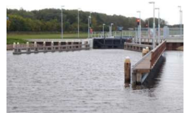
De nieuwe sluis bij de A7.
